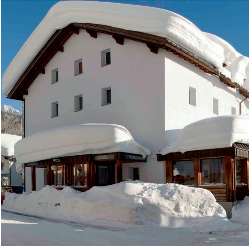
Das Hotel nach der Fassadenrenovierung 2009
