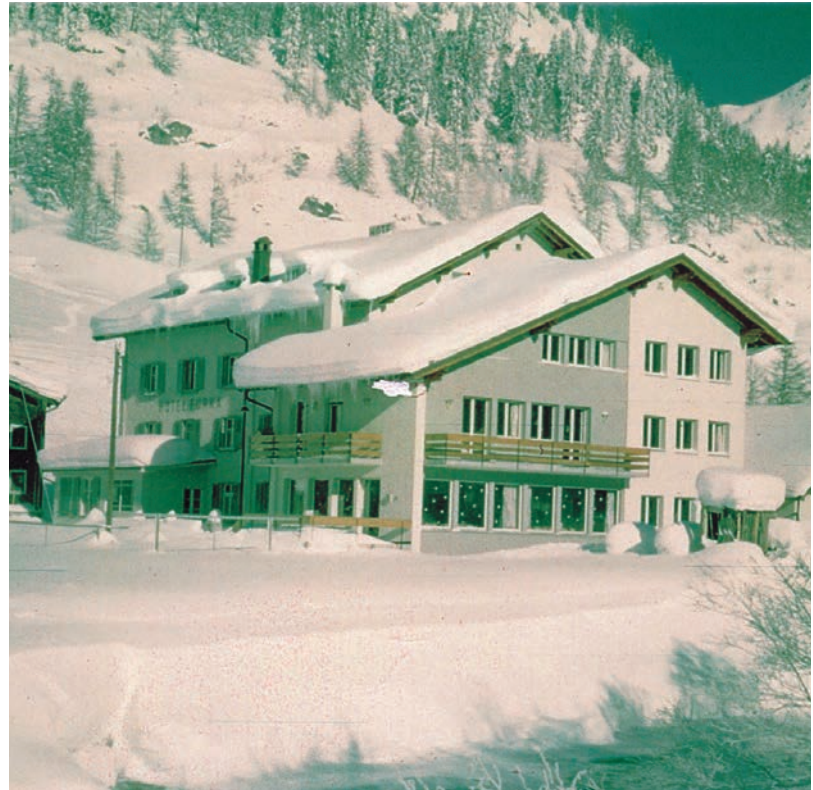
Das Hotel nach dem Umbau 1961
