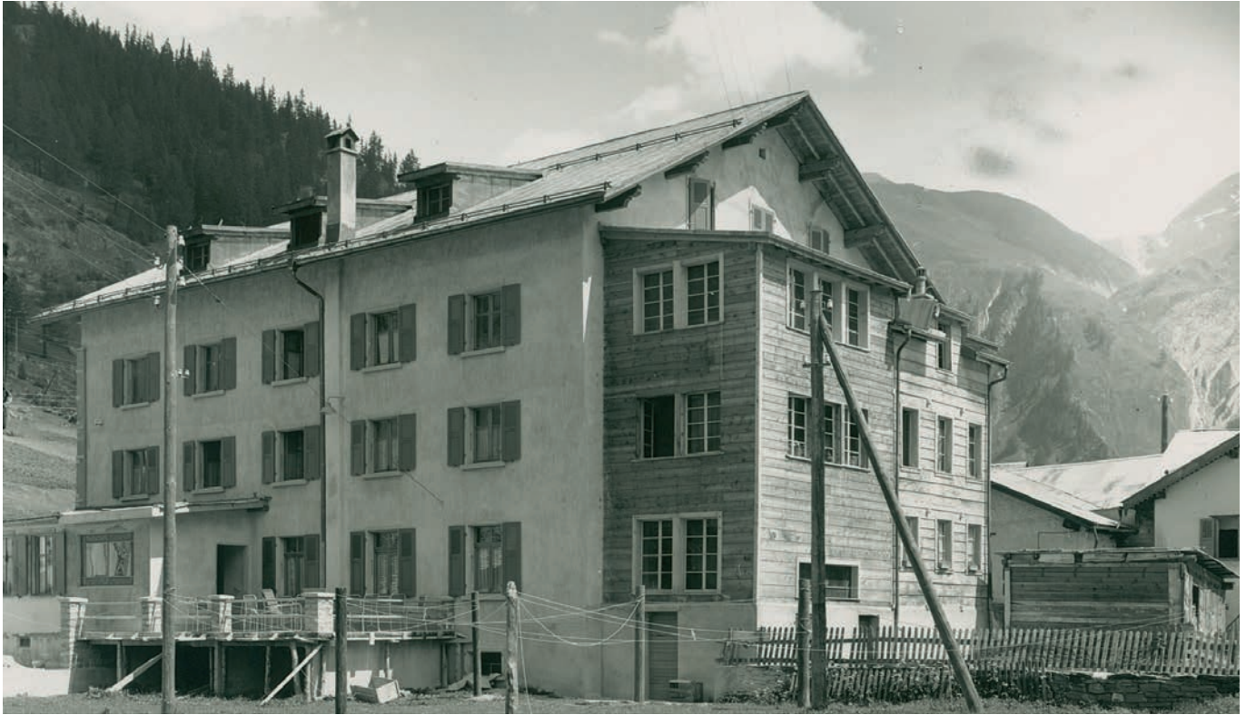
Der Holzanbau aus dem Jahre 1954, der bereits 1961 abgerissen und ersetzt wird.
