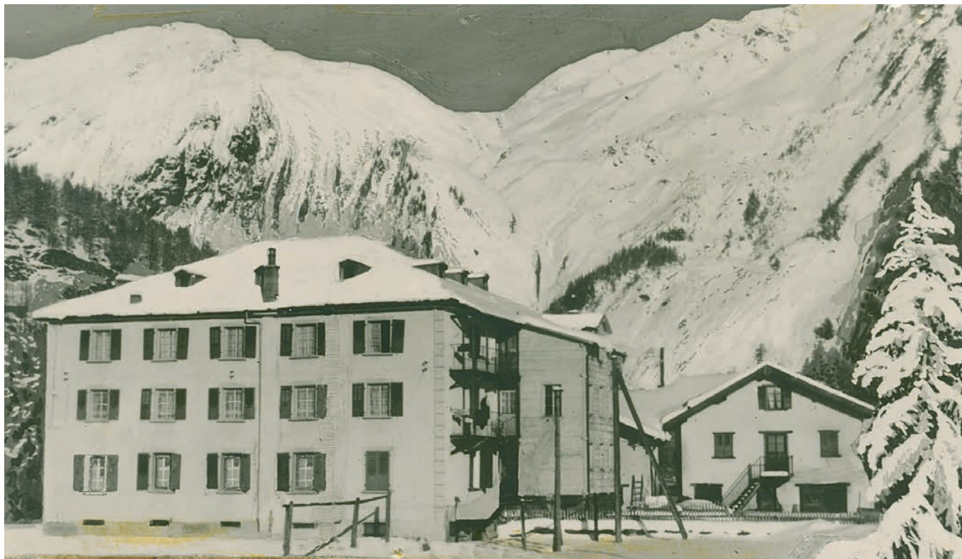
Anfang der 30er Jahre wird eine Holzbaracke angebaut, in der weitere Zimmer untergebracht sind.
